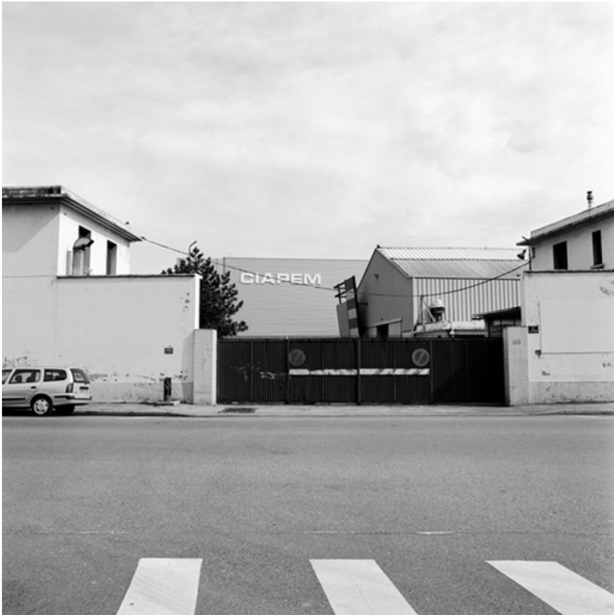
Entrée livraisons au 163 rue de Gerland, ancienne entrée de la société chimique de Gerland.
