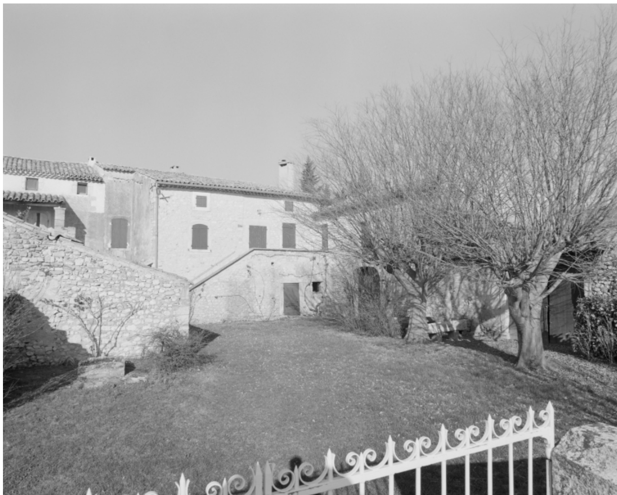
Les Planes (ZC 75). Ferme, Vue d'ensemble.
