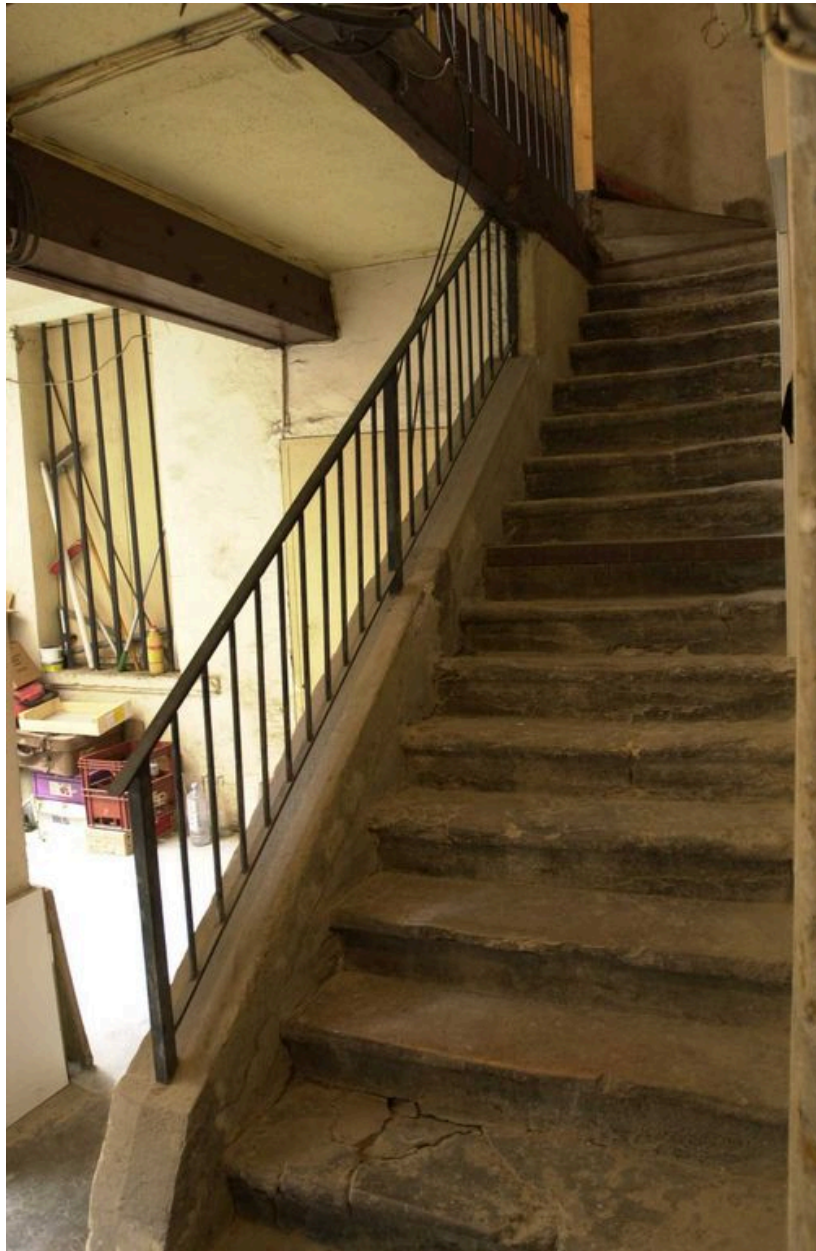
Vue de l'escalier de distribution extérieur, sur cour
