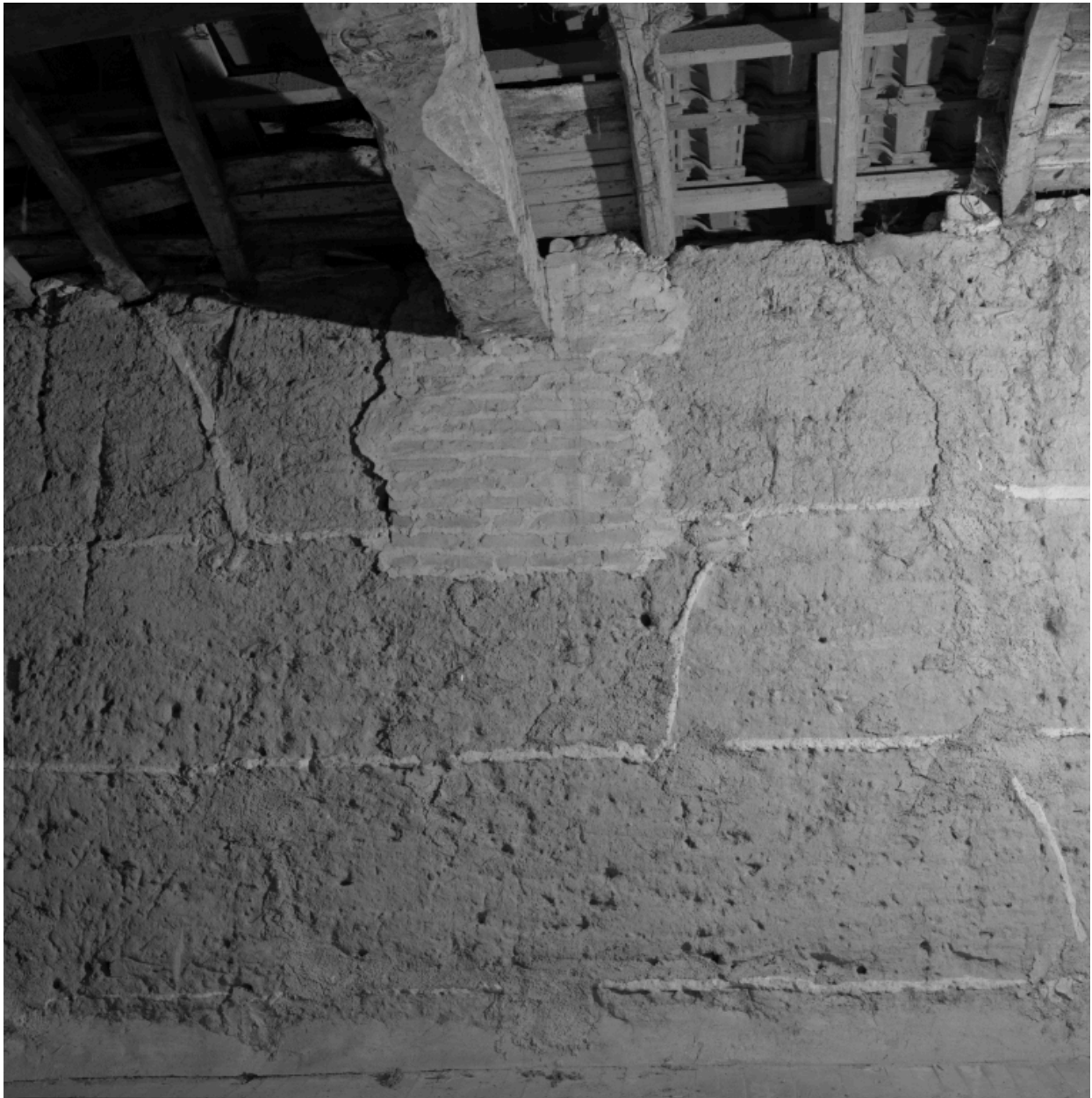
Semelle en briques permettant de maintenir une poutre de ferme dans un mur en pisé.
