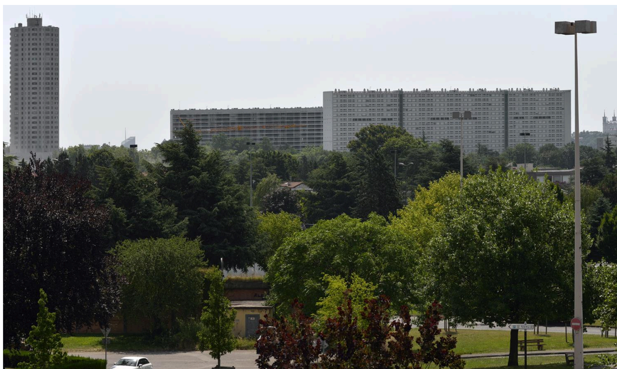
Vue après démolition
