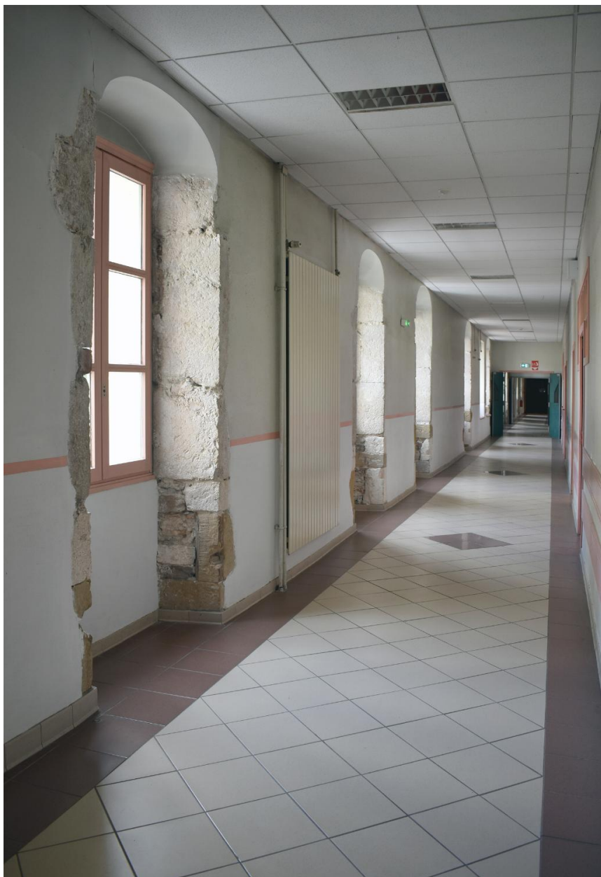
Bâtiment A : couloir du 1er étage, depuis le nord
