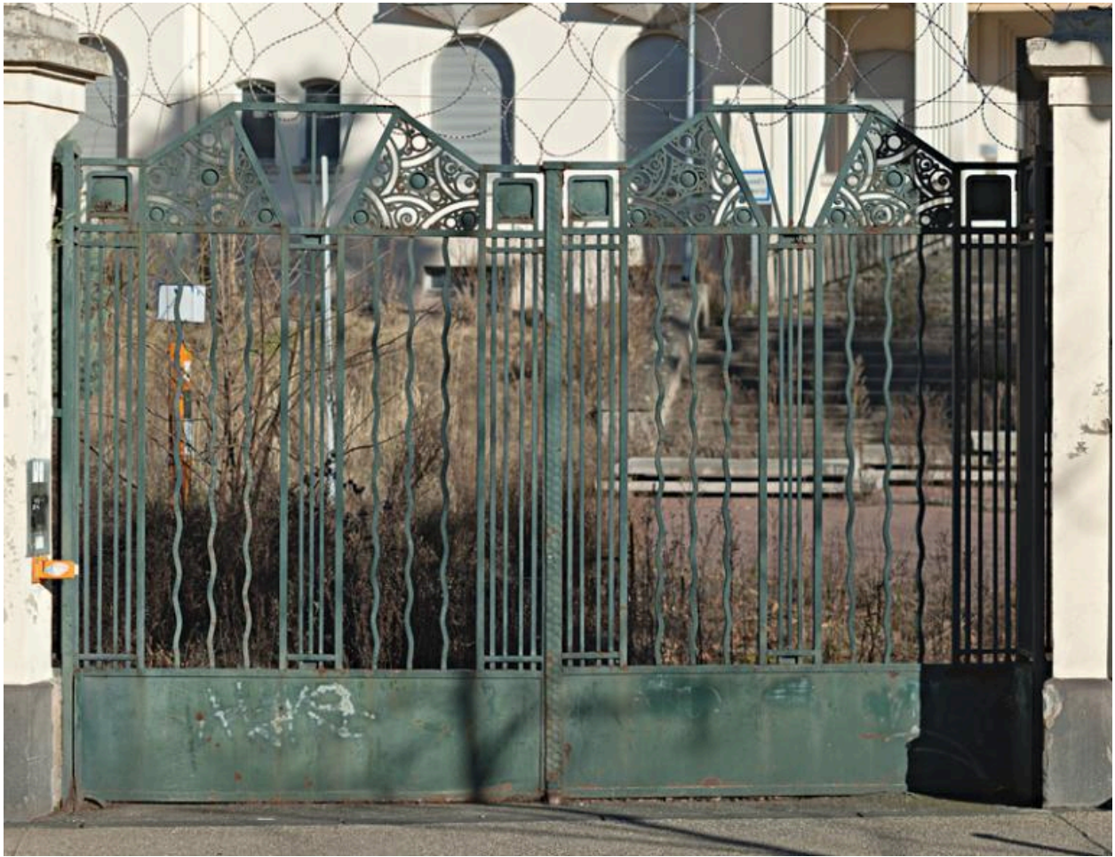
Hôtel-Dieu de Clermont-Ferrand. La polyclinique, grille de la porte flamande (vue de l'ouest).
