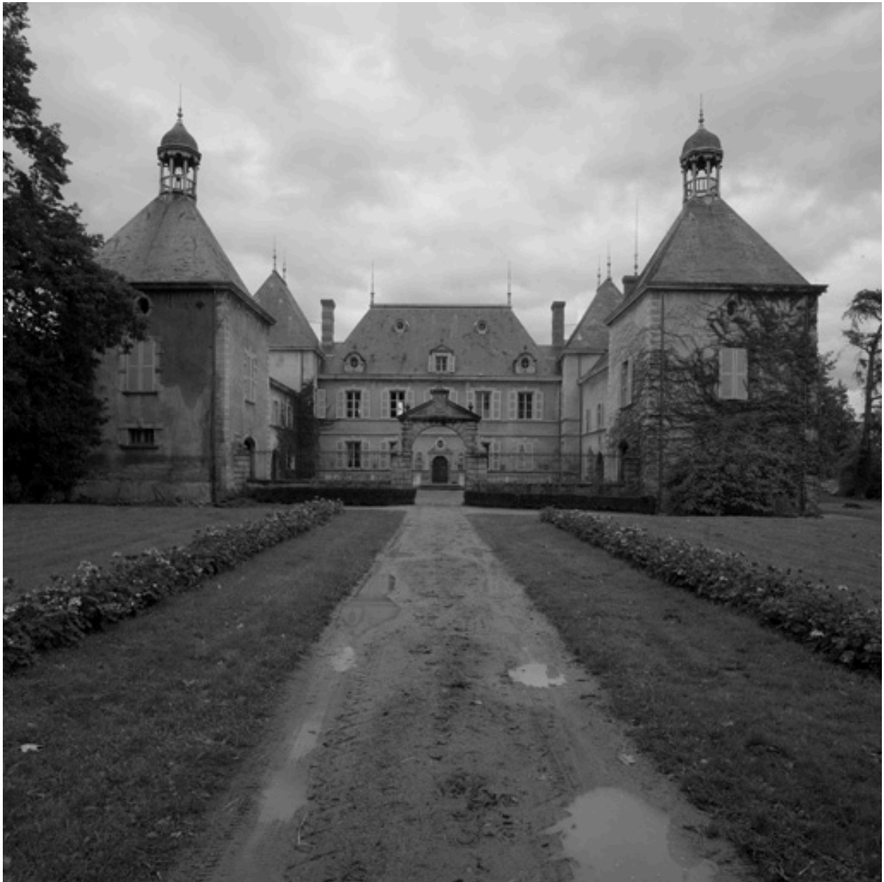
Vue d'ensemble depuis le sud (grille ouverte).
