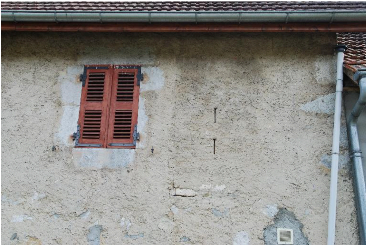
Détail des jours du placard mural, façade arrière de la ferme.
