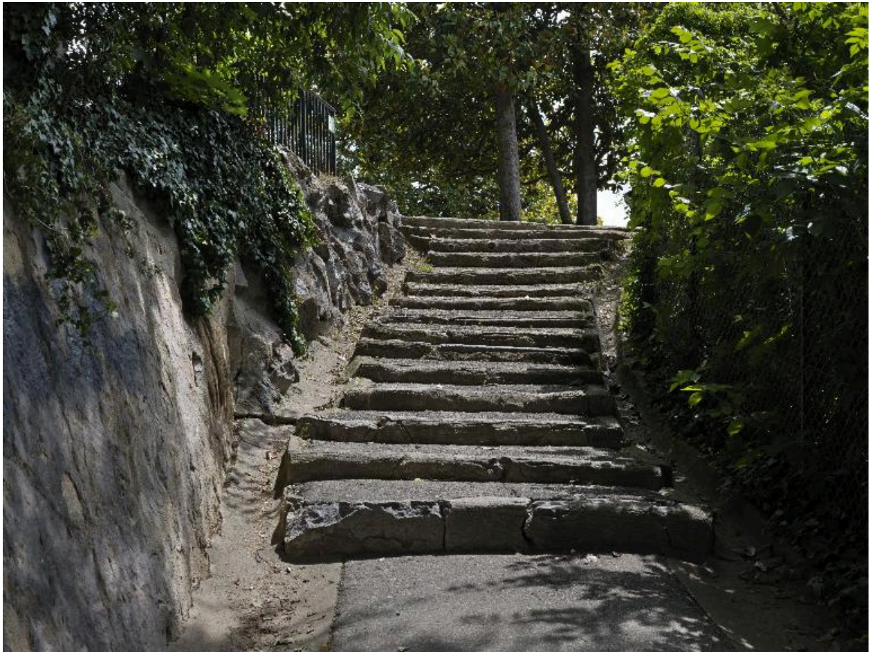
Partie sud-ouest du jardin : escalier en pas-d'âne, en ciment imitant des troncs d'arbres écotés
