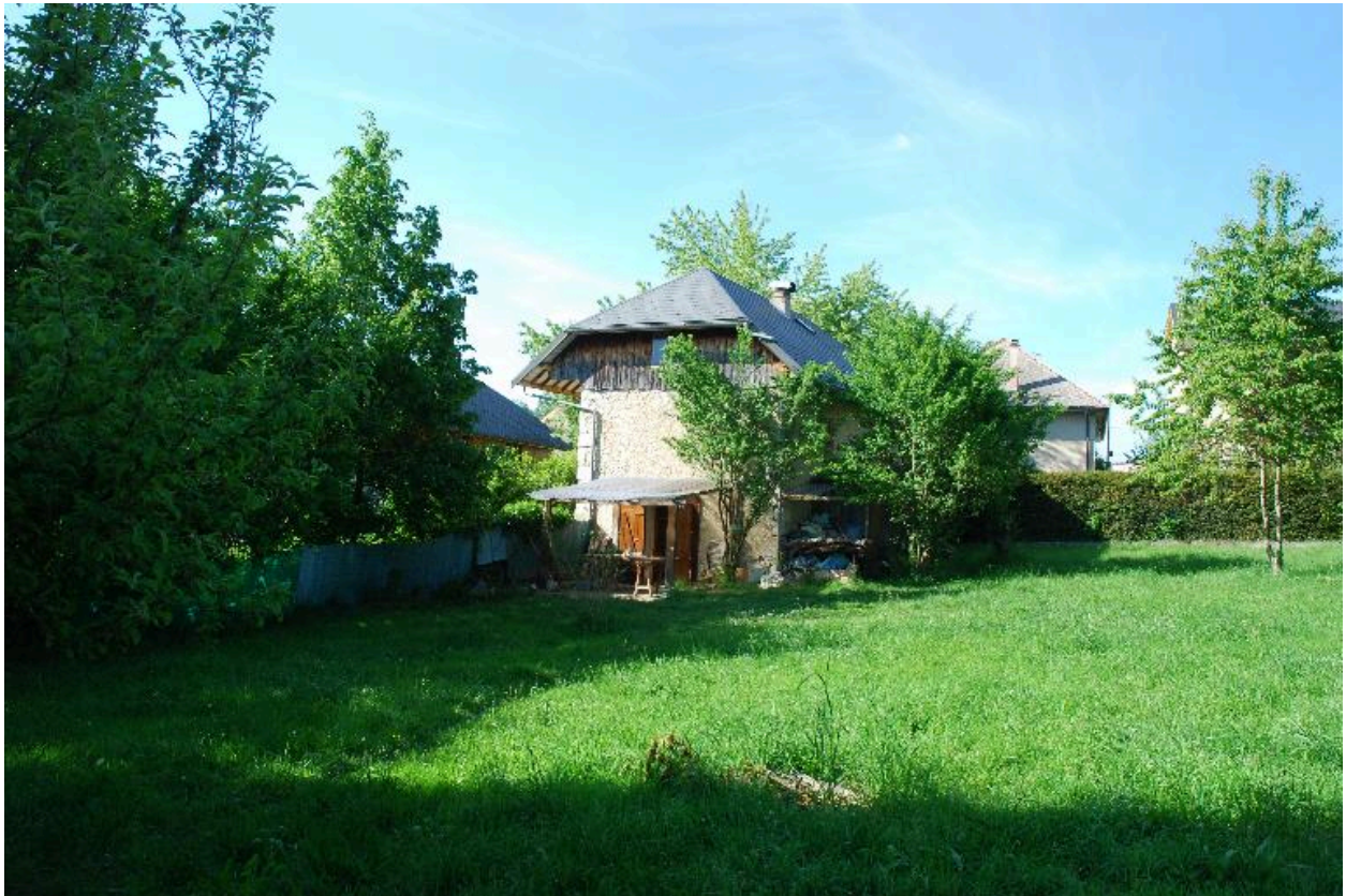
Le Bourg, ferme (2013 D2 911), Vue d'ensemble arrière de la ferme.
