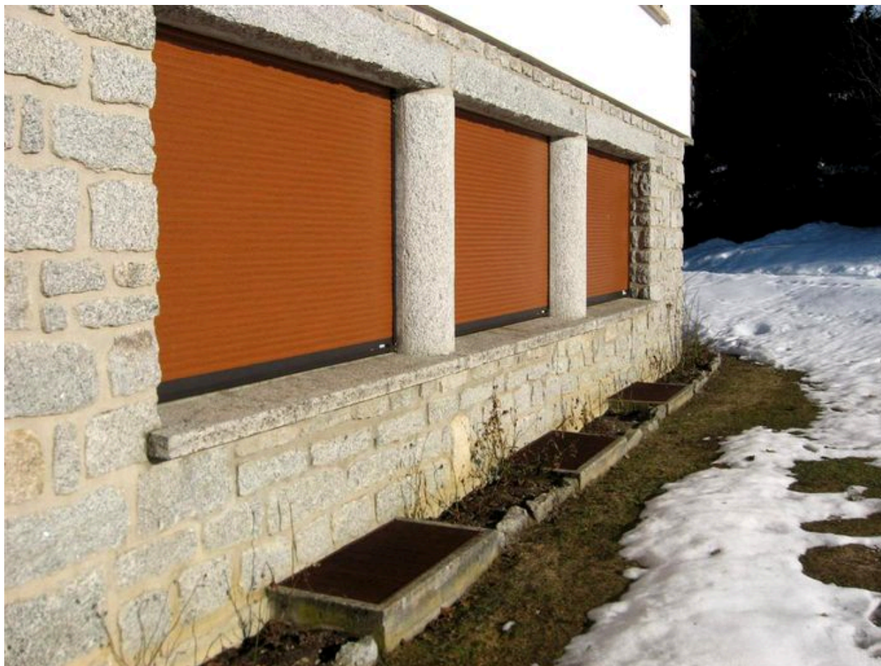
Détail des baies du rez-de-chaussée surélevé
