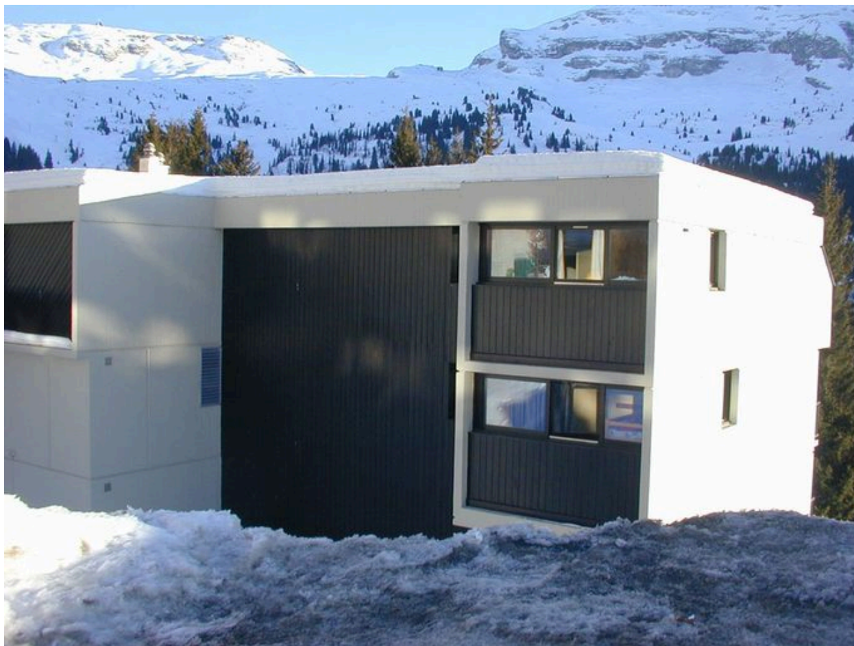
Elévation principale, partie ouest
