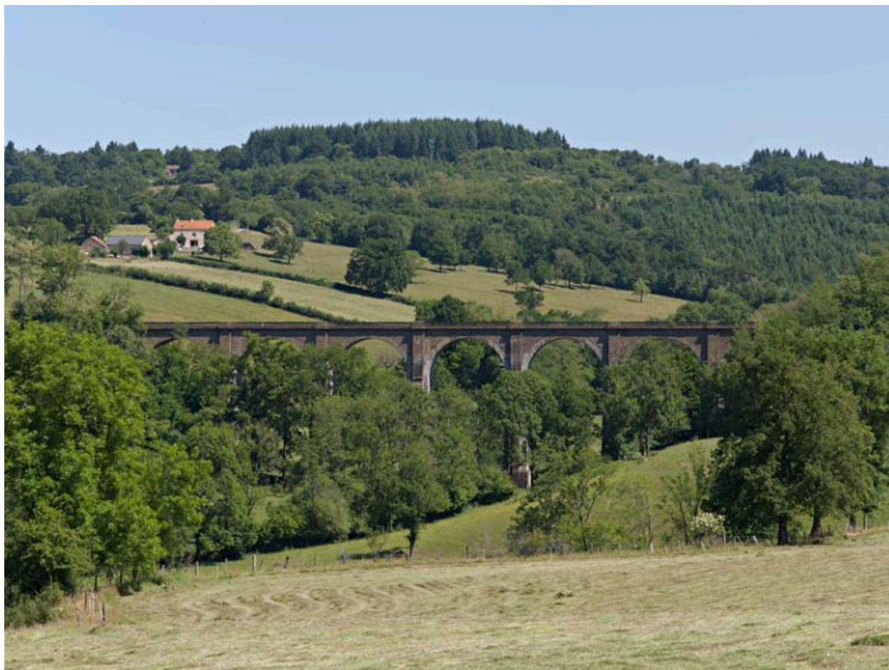
Vue générale du viaduc dans le site, depuis le sud.
