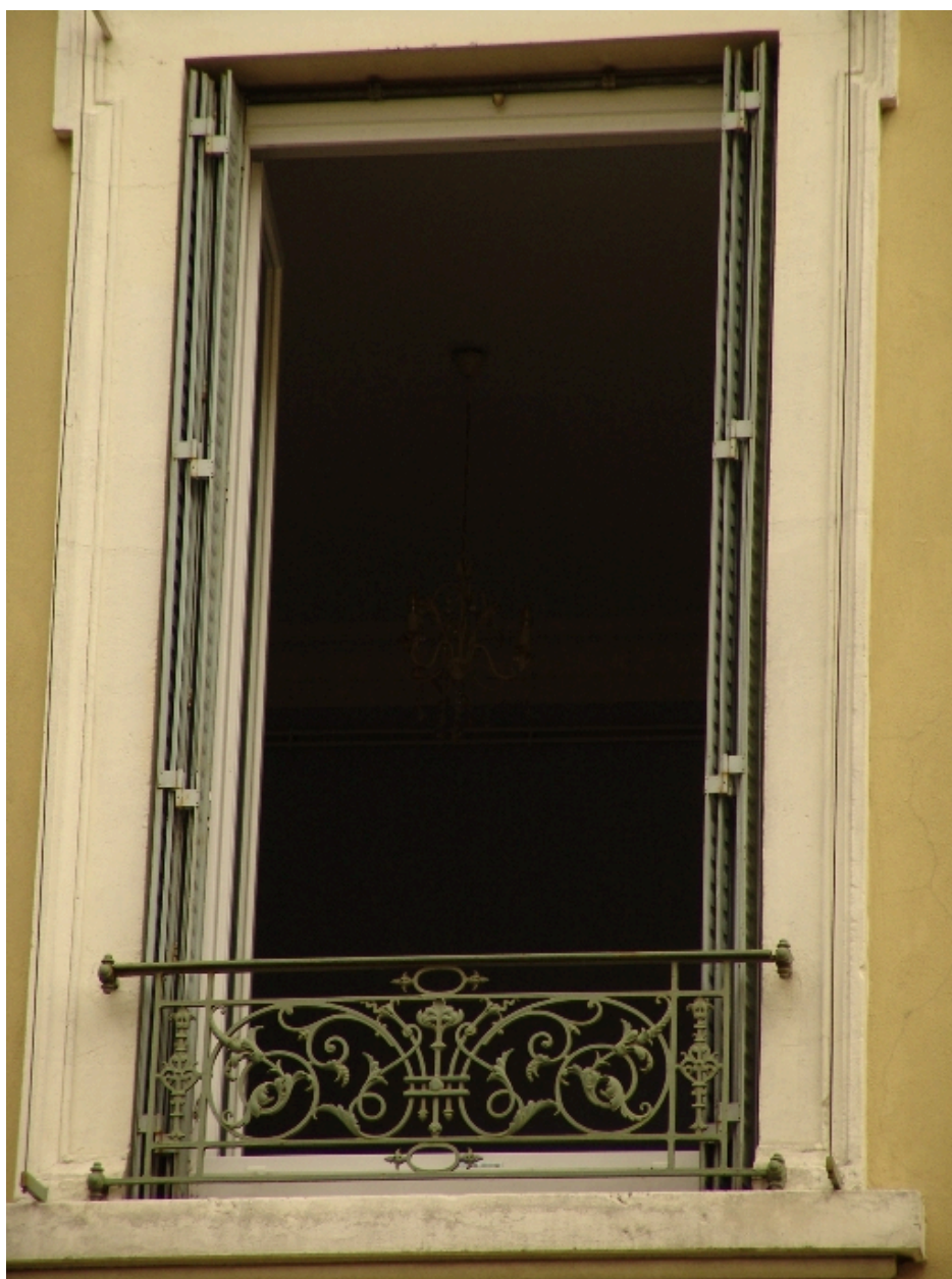
Détail d'un garde-corps
