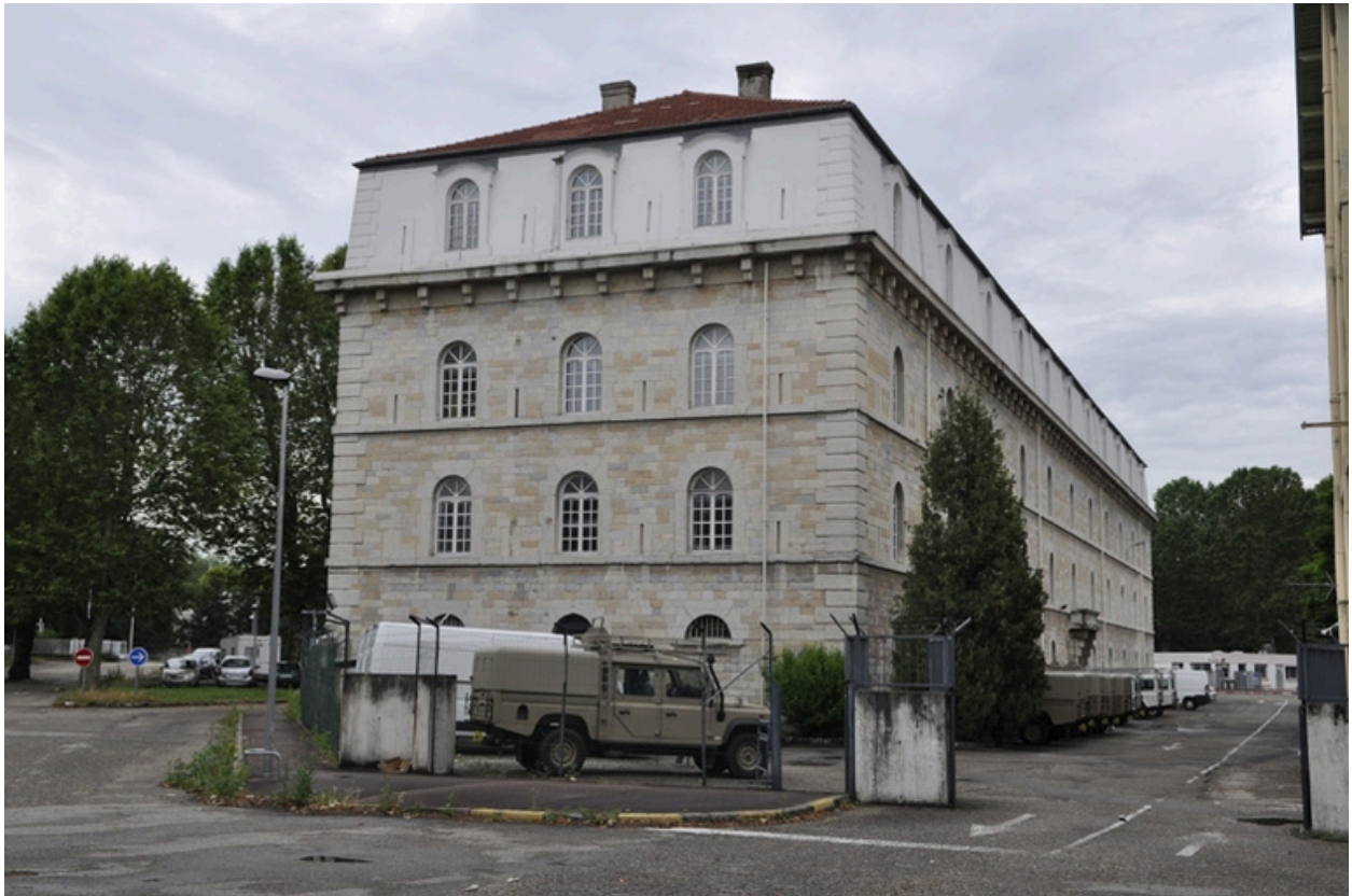
Vue du bâtiment principal: pignon ouest.
