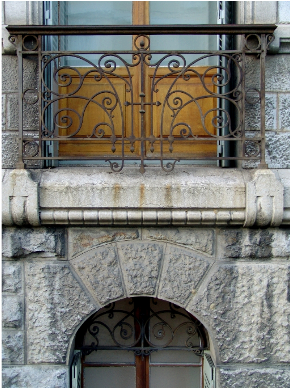
Détails sur façade
