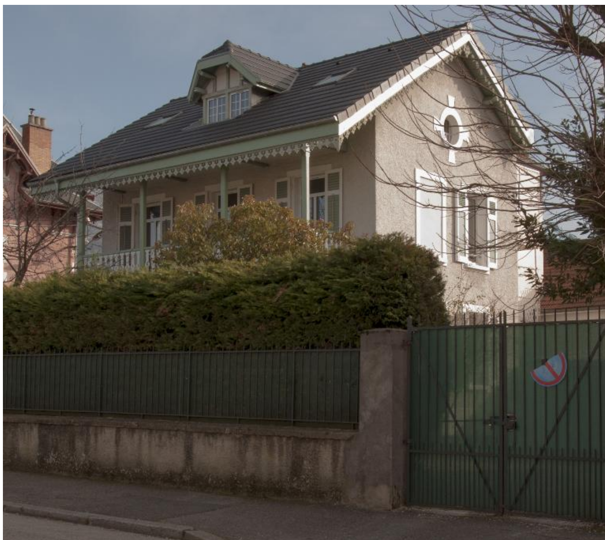
Façade nord et pignon ouest
