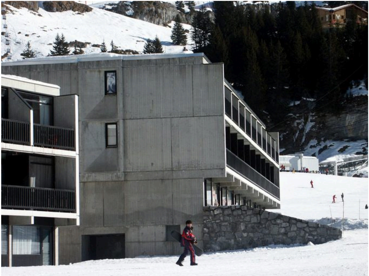
Vue depuis l'ouest
