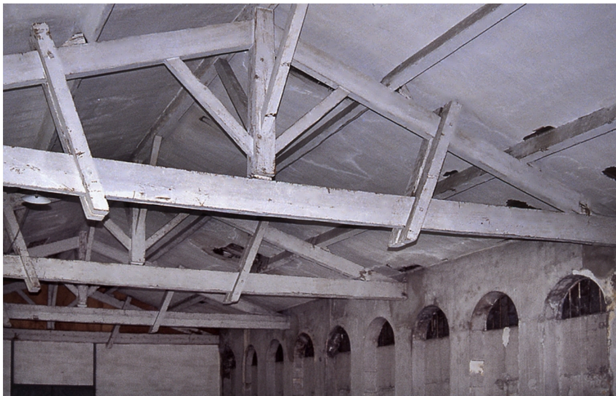
Charpente en bois, atelier sud
