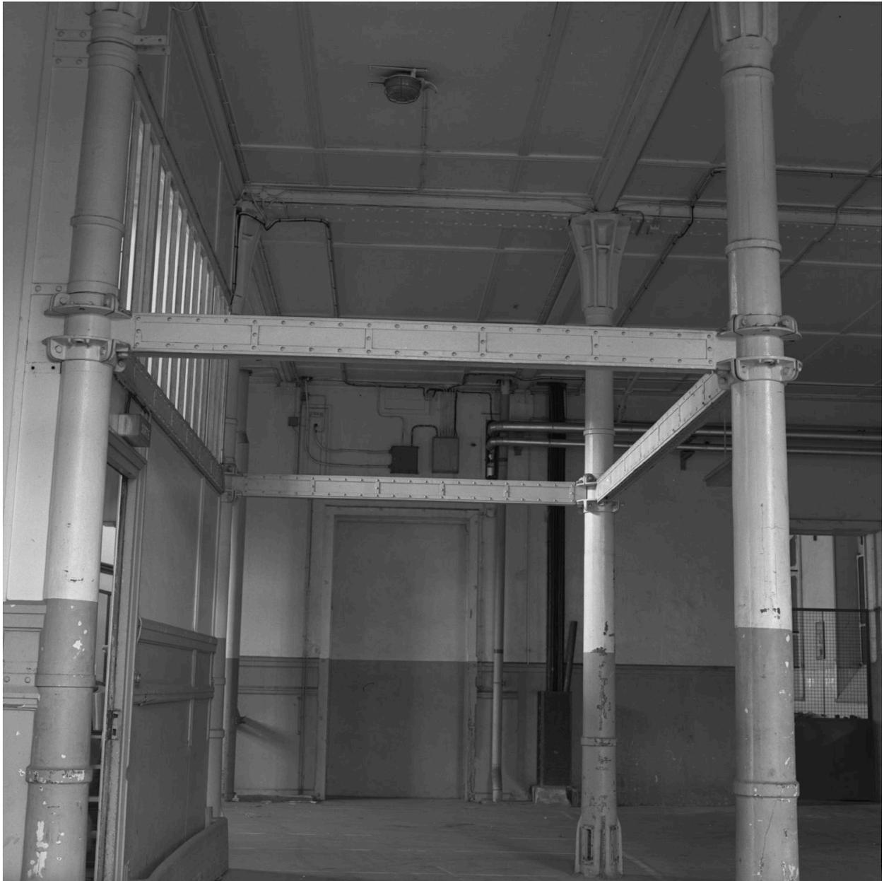
Rez-de-chaussée du pont de service nord : colonne et poutelle
