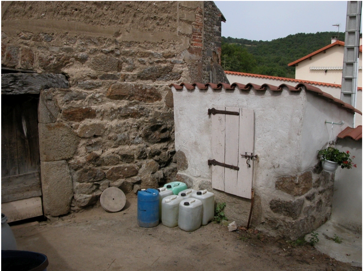
Vue du puits (première cour, à côté de l'entrée de la cave).
