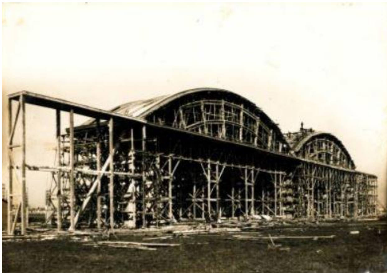
Hangar VI photo chantier ETs. Boussiron en 1925 (ADR : 4535W47)
