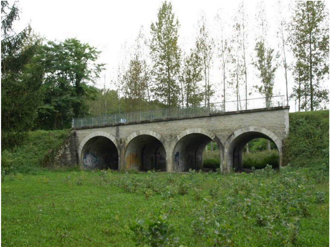
Corps de quatre travées qui prolonge l'ouvrage en rive gauche
