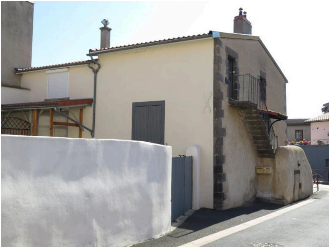
Vue latérale gauche de la maison
