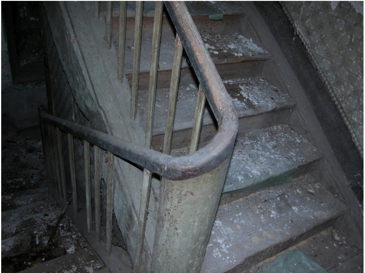
Vue de l'escalier.
