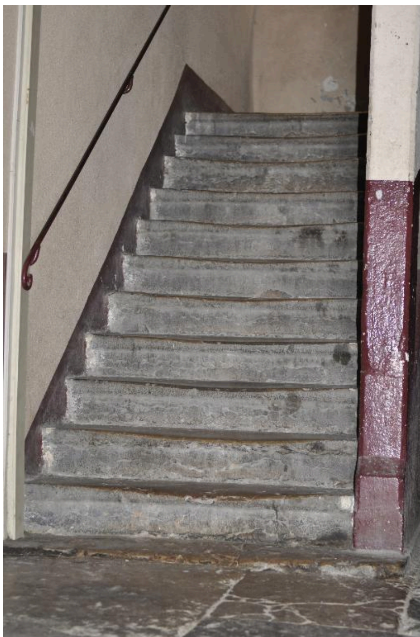
Vue d'une volée de l'escalier du n°15 rue Dumenge
