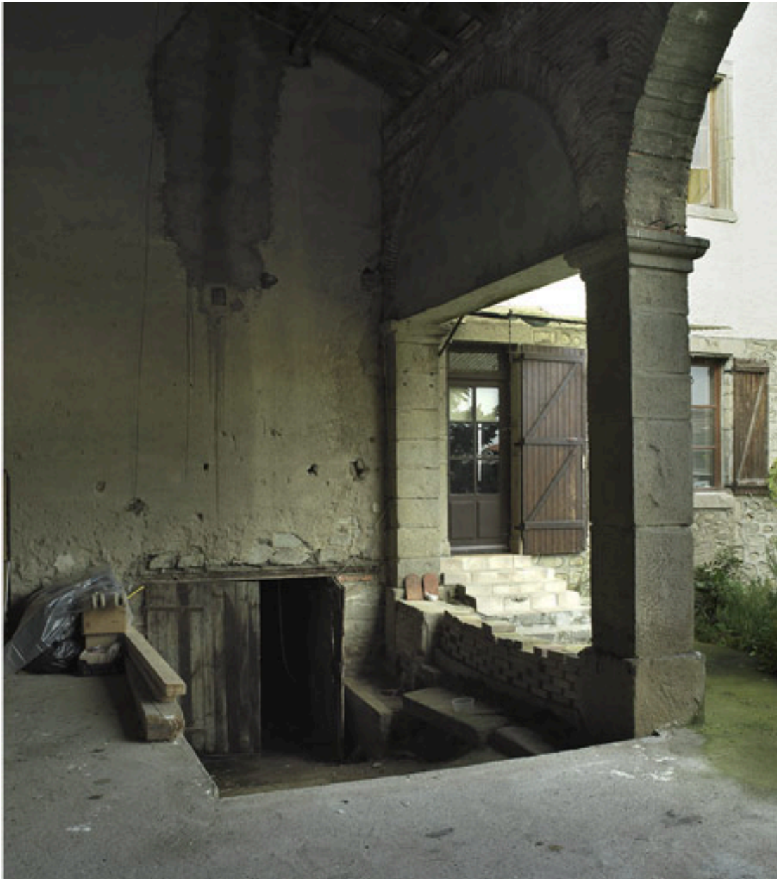
Vue intérieure du passage couvert : accès vers la cave.
