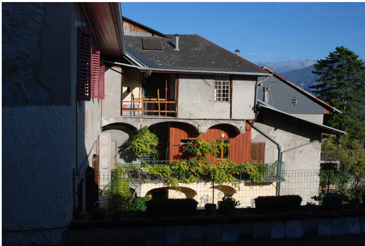
Maison, immeuble, 125 rue Louis Blanc-Pinget (2018 E1 2071). Vue des élévations sur cour depuis le sud-ouest.
