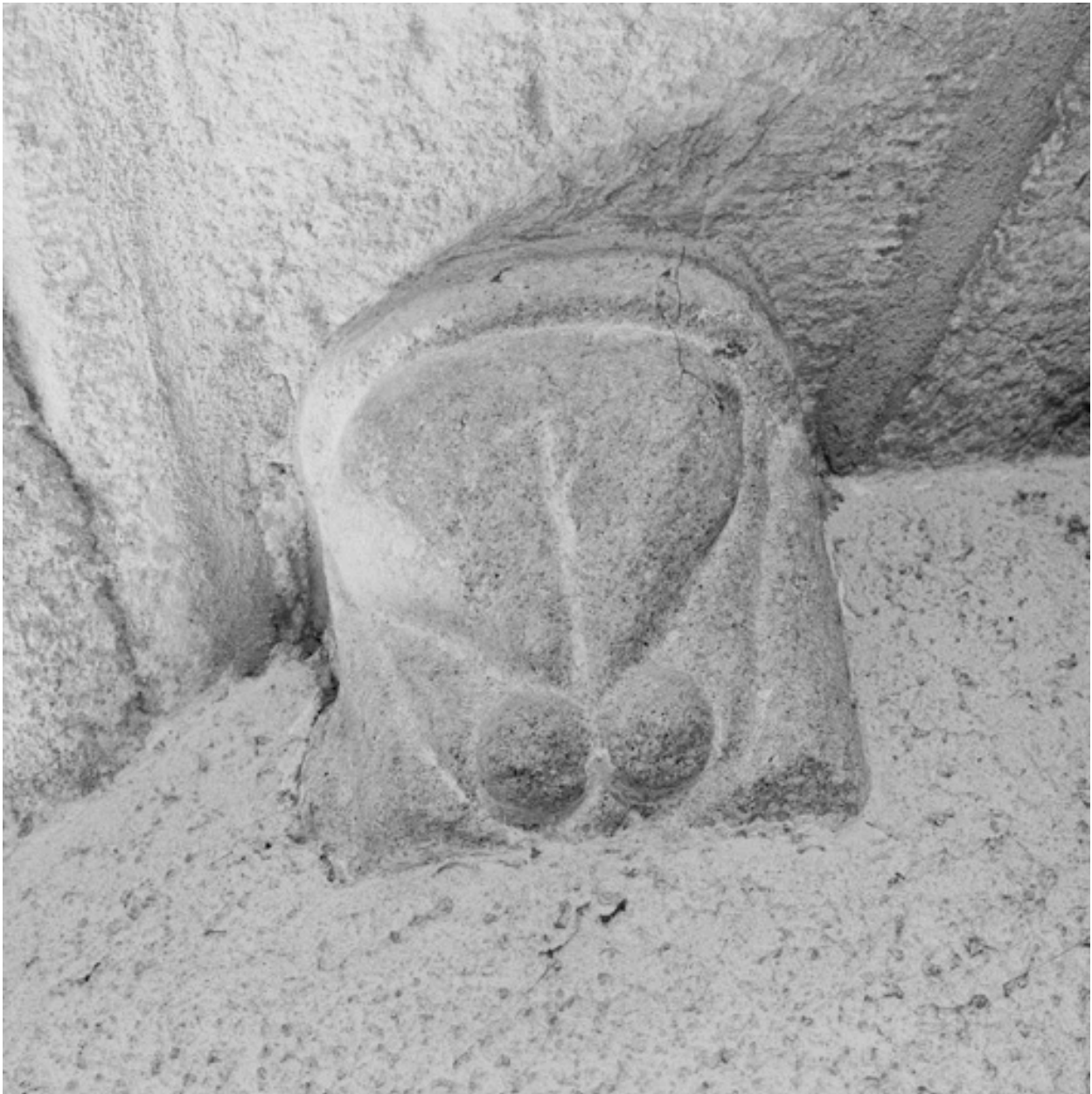
Console d'escalier soutenant un dessous de marche.
