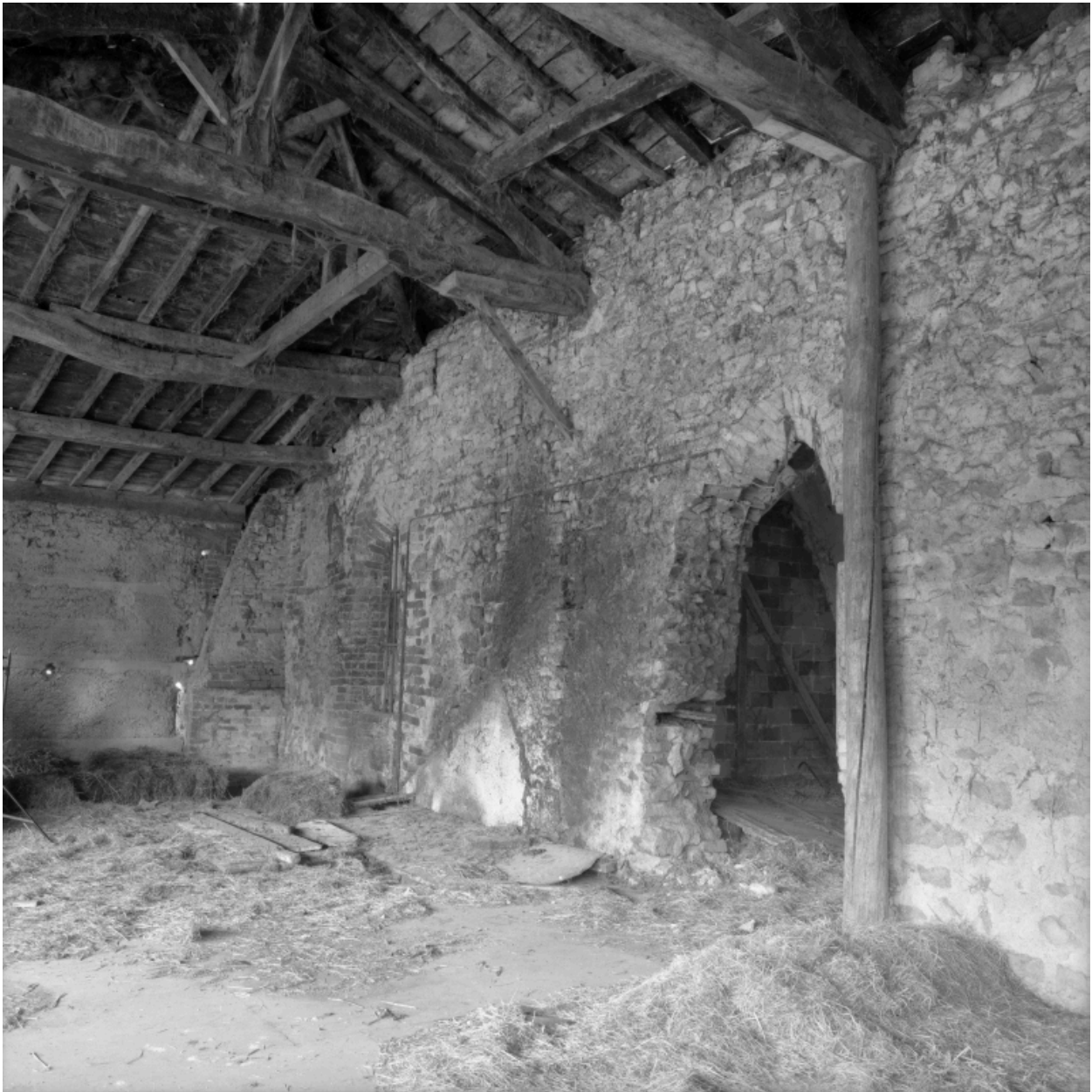
Façade nord, détail de la partie occidentale.
