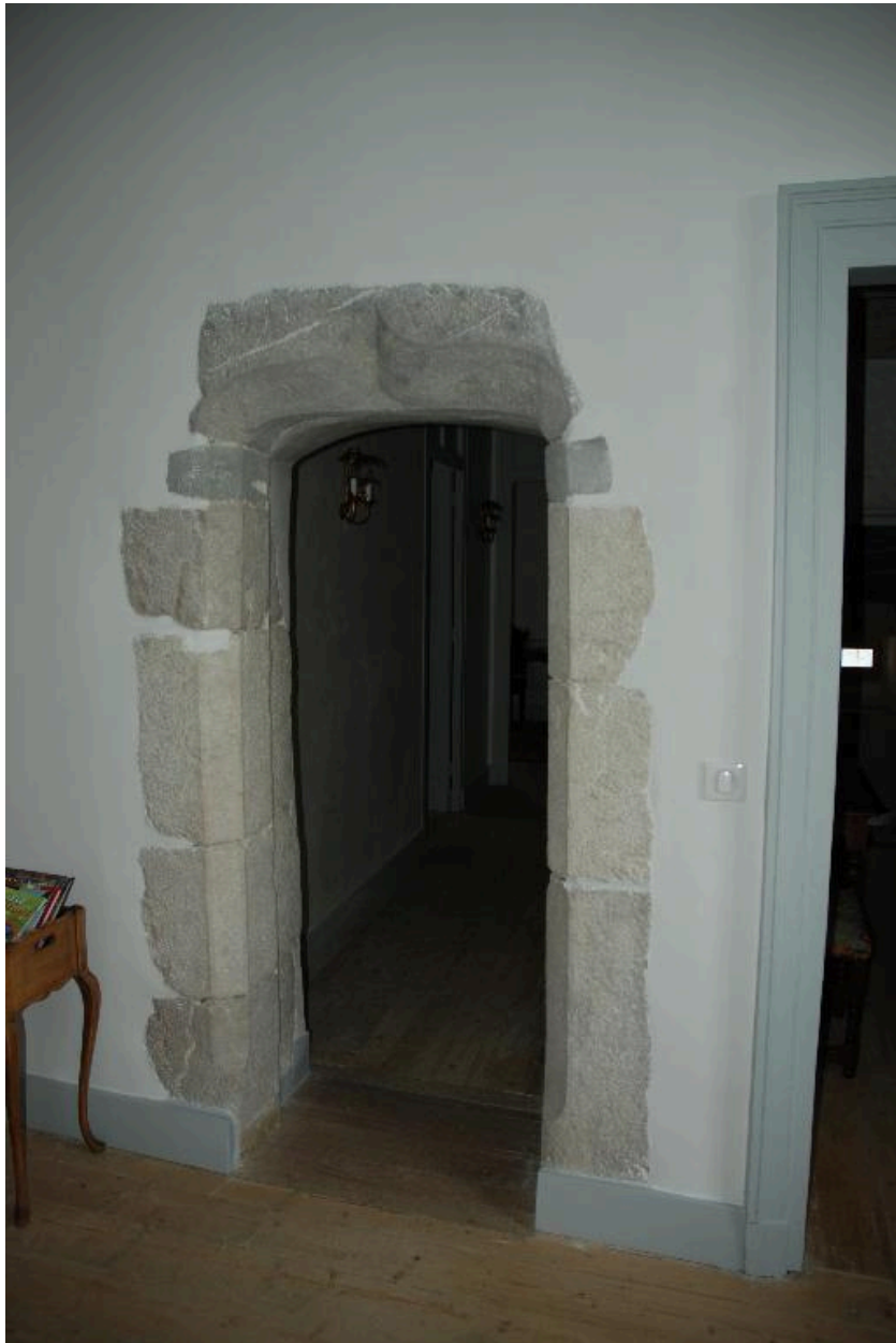
Deuxième étage. Porte d'accès au couloir desservant deux chambres.
