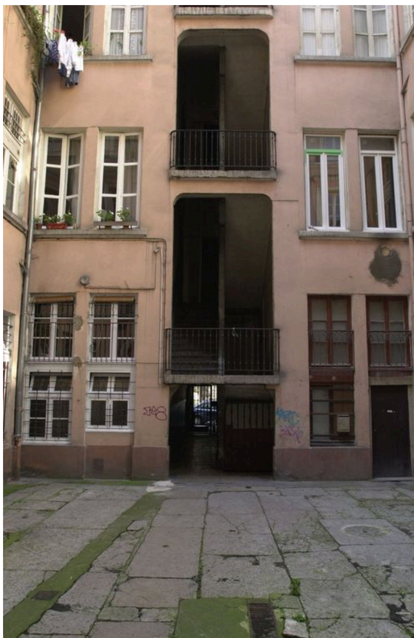
Vue de la cage d'escalier en revers de façade
