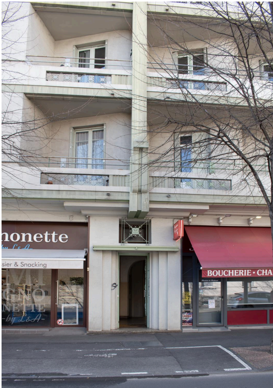
Détail: porte d'entrée et travées centrales
