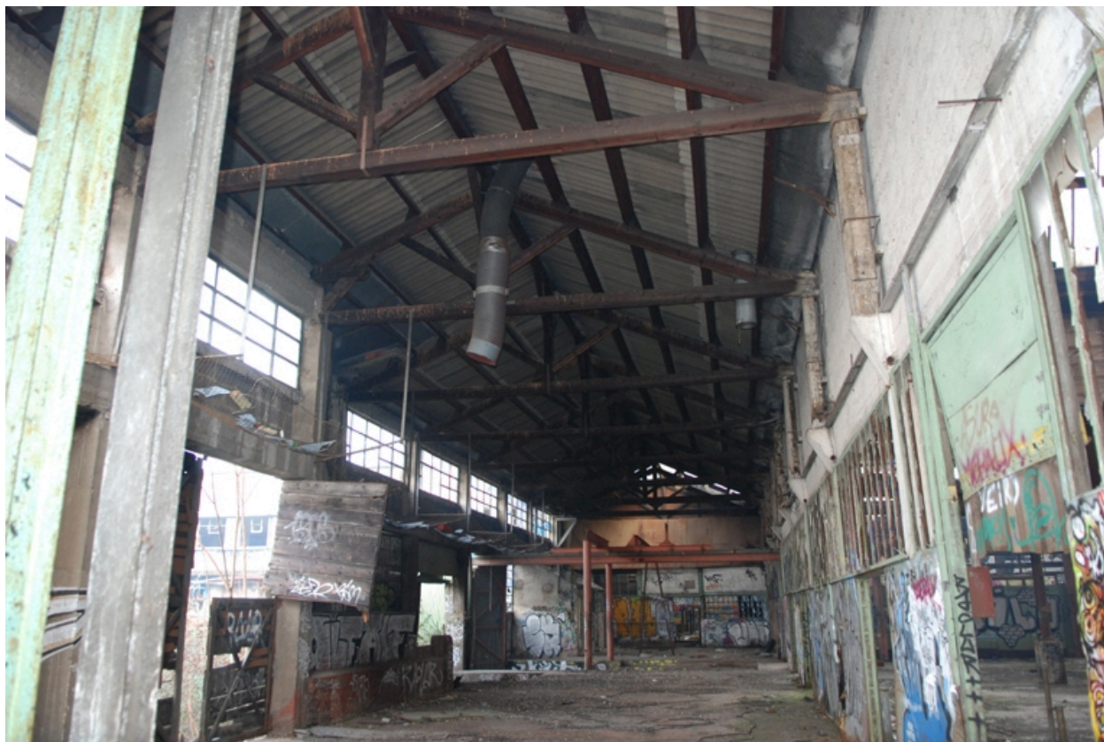
halle avec charpente en bois
