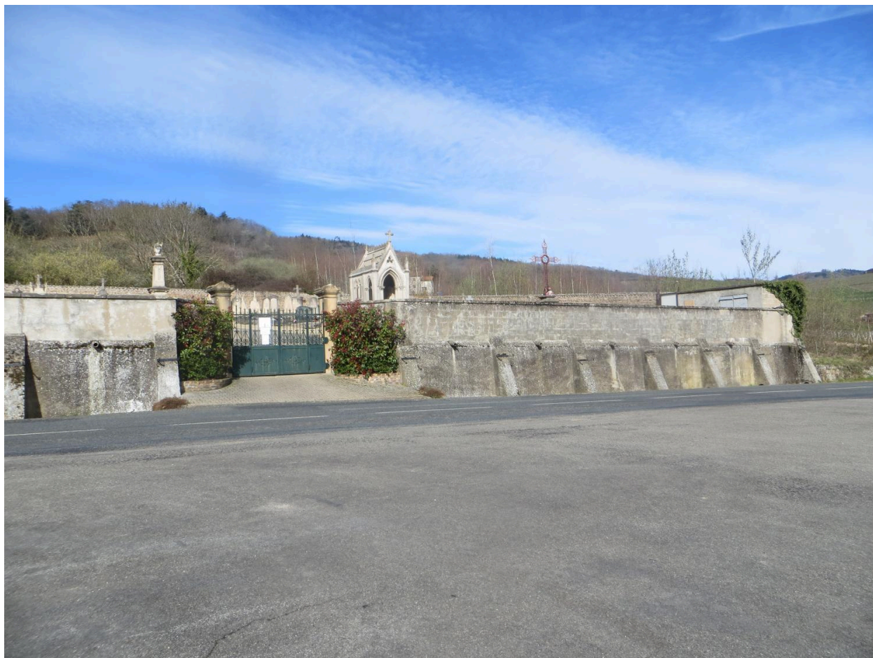
Vue partielle depuis la route
