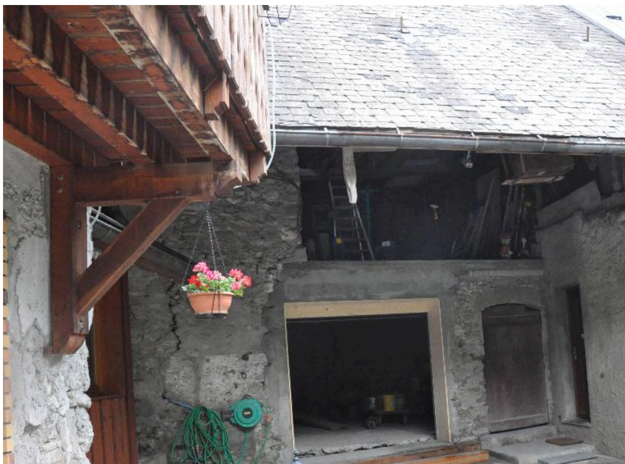
Vue de la partie occupée par le moulin à huile actuellement remaniée pour devenir un garage.
