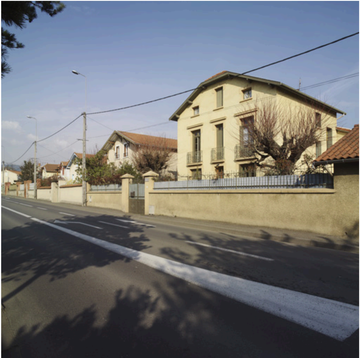
Rue de Feurs, ensemble de maisons pavillonnaires, début 20e siècle.
