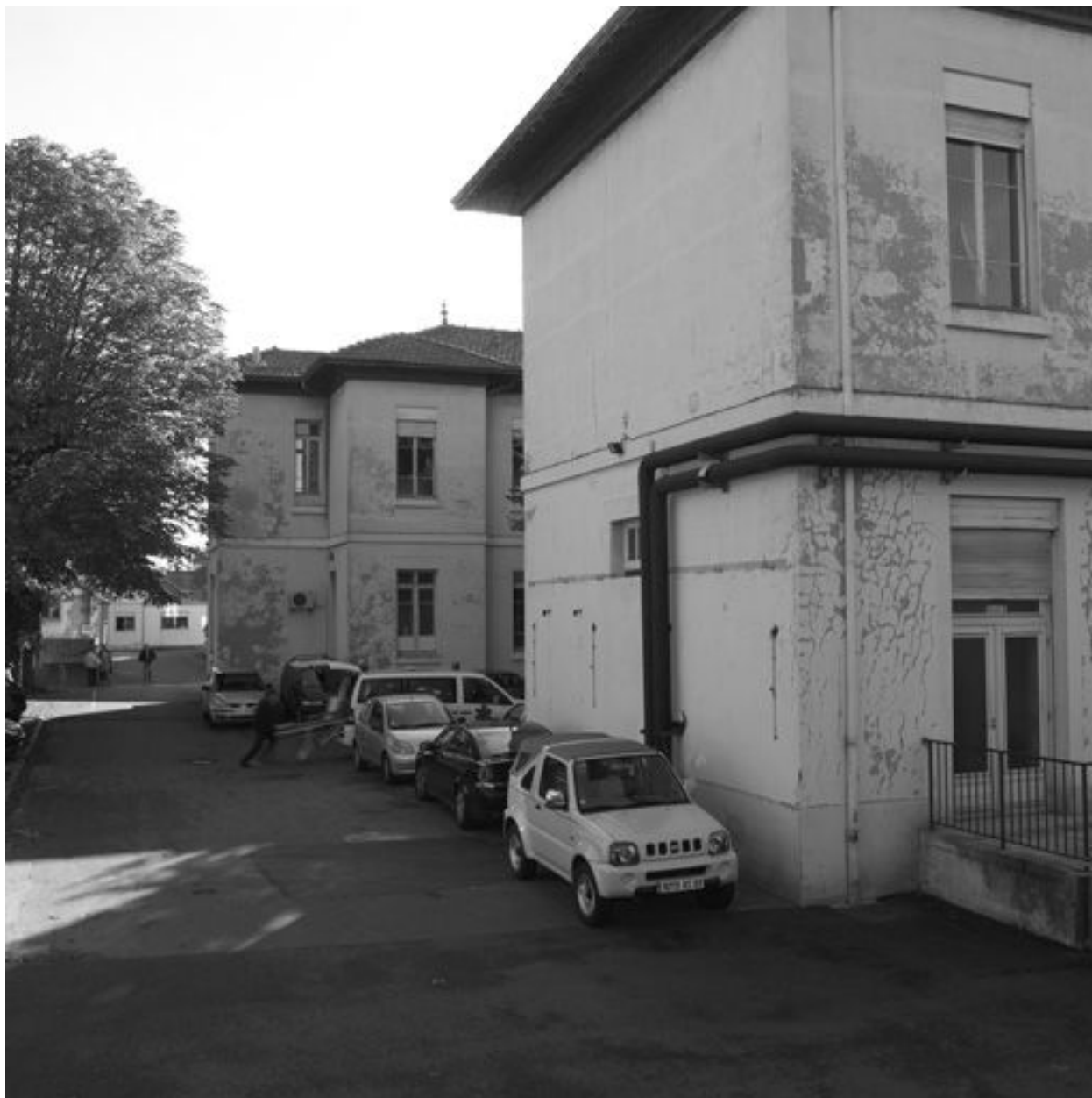
Bâtiment RST, ailes R et S vues du côté nord
