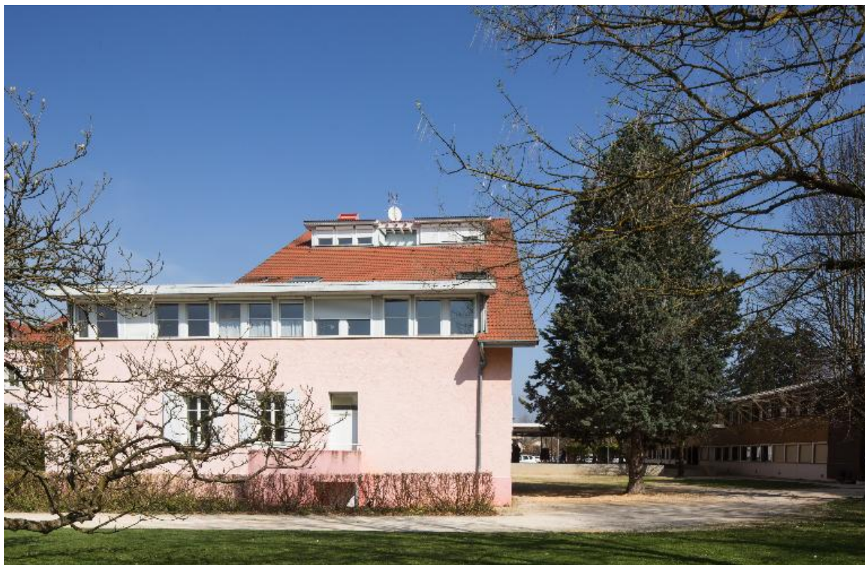
Bât. A : façade latérale au sud de l'aile est
