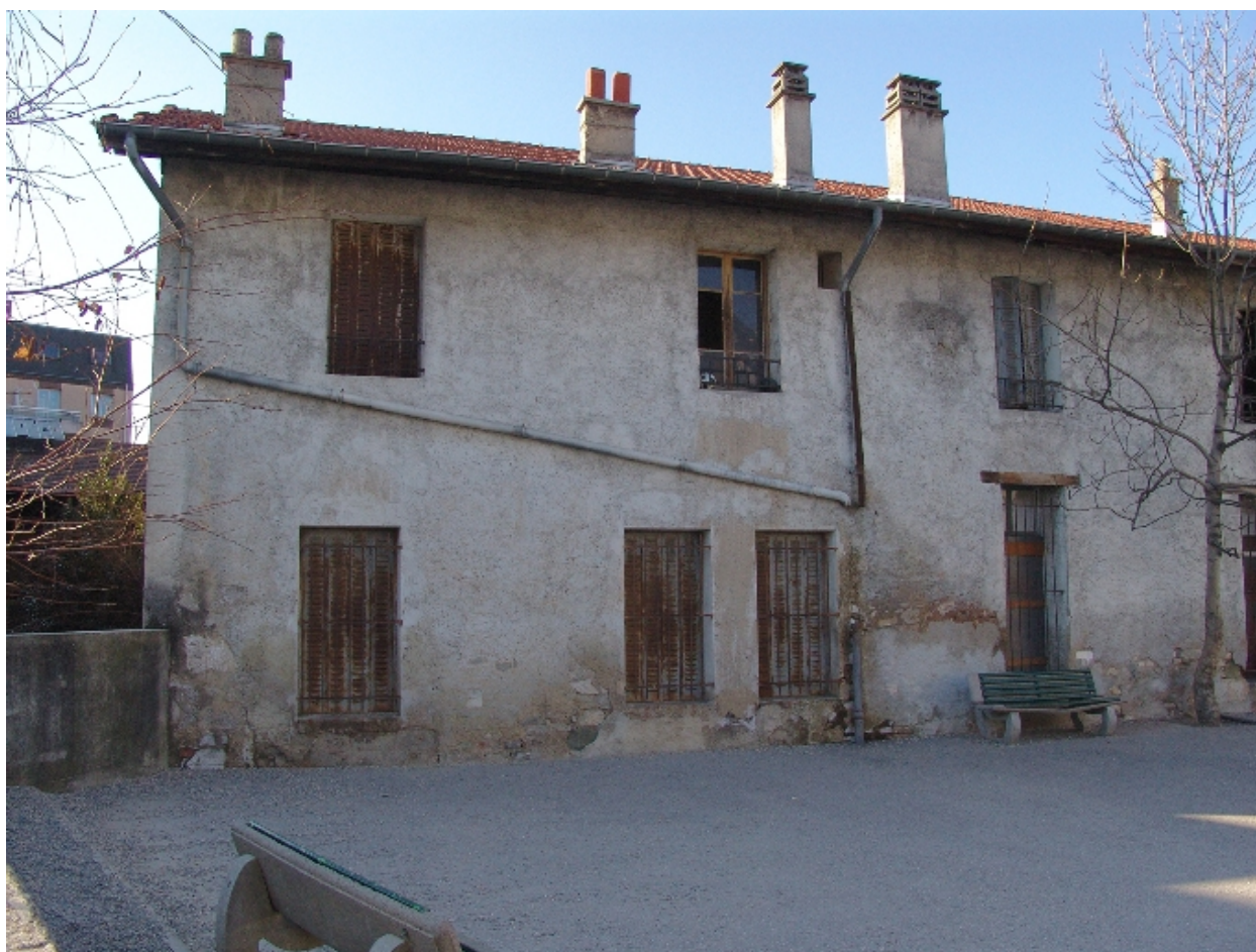
Façade, partie gauche
