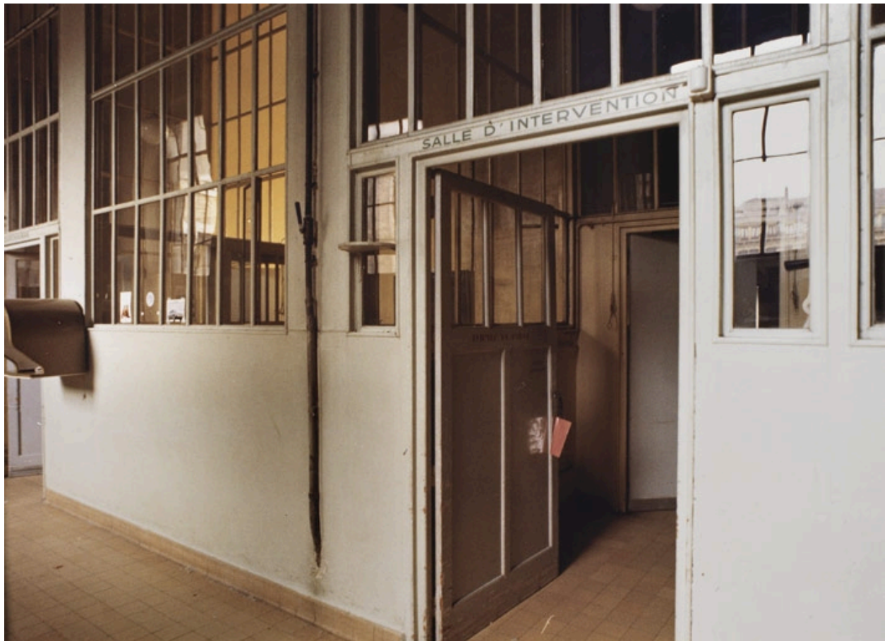
La salle Sainte-Marguerite (maternité) avant travaux. Photographie, mai 1981 (A. Musée des HCL. AF 53)
