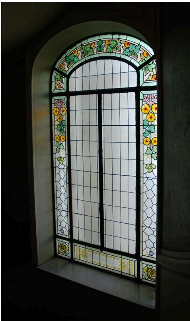
Verrière éclairant l'escalier, étages intermédiaires
