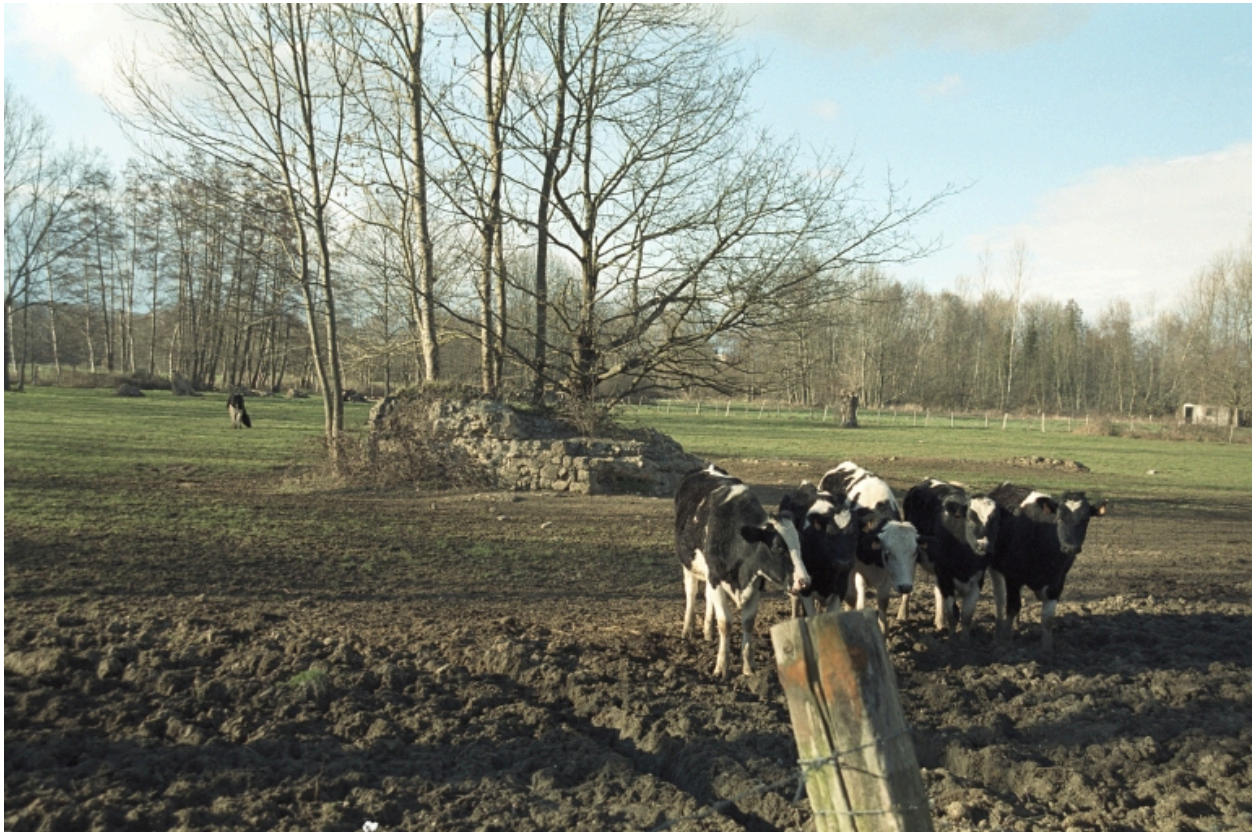
Vue des restes des piles du pont sur le Lignon, à Mérizat (Montverdun ? ZB 79).
