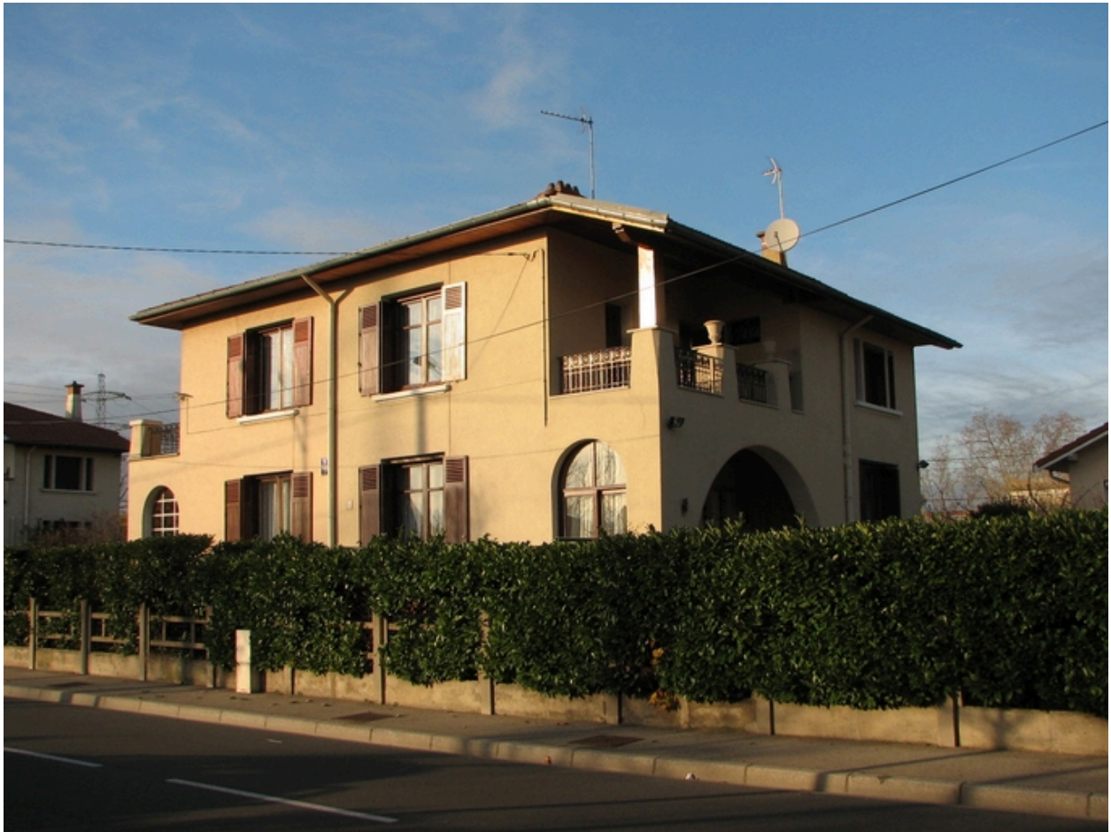
ancien presbytère façade est
