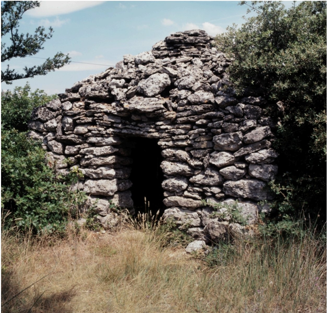
Chamaret. Les Chamblas. Vue générale de la cabane.
