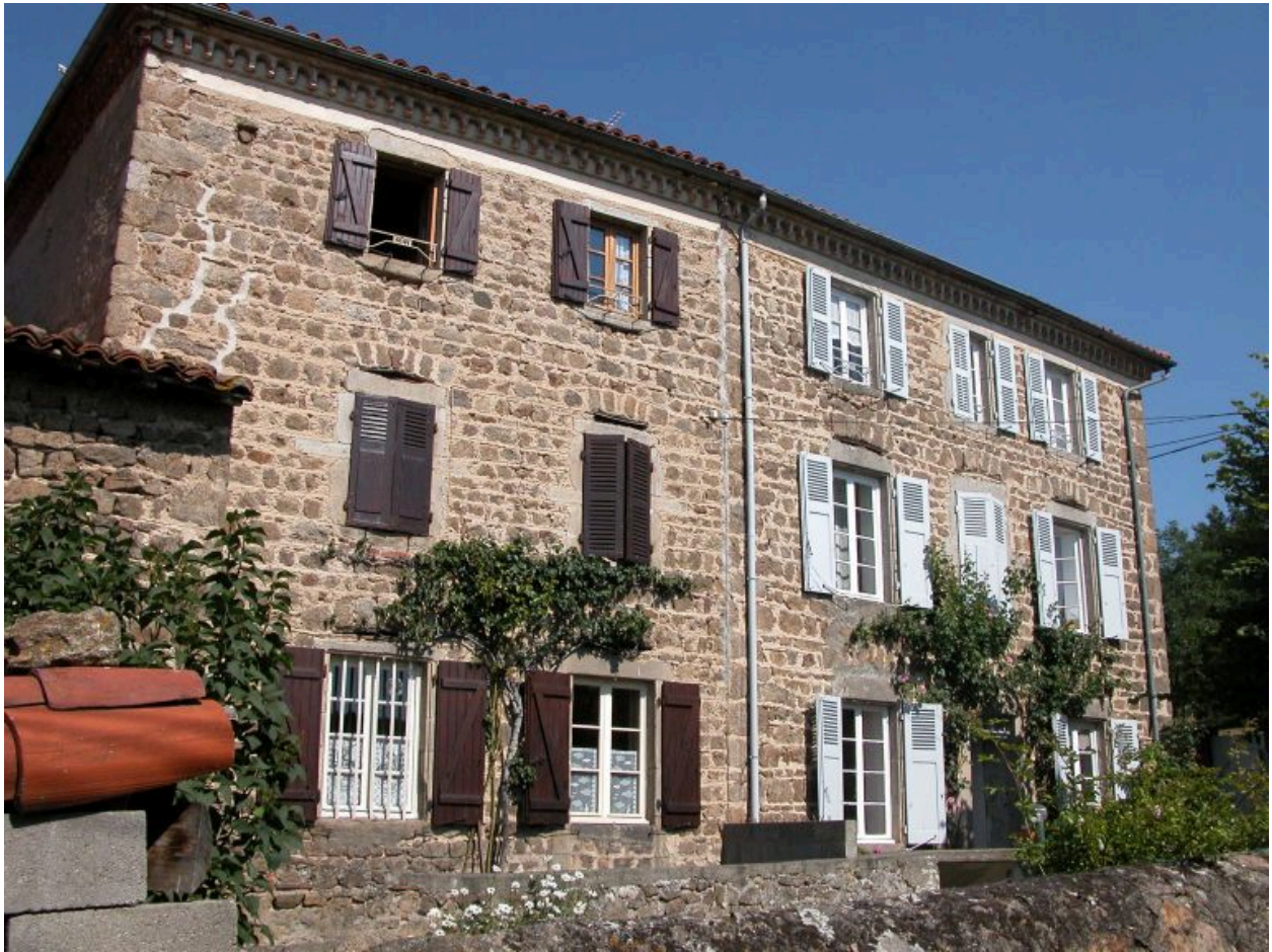
Vue d'ensemble de la façade du logis depuis la cour haute du logis mitoyen.
