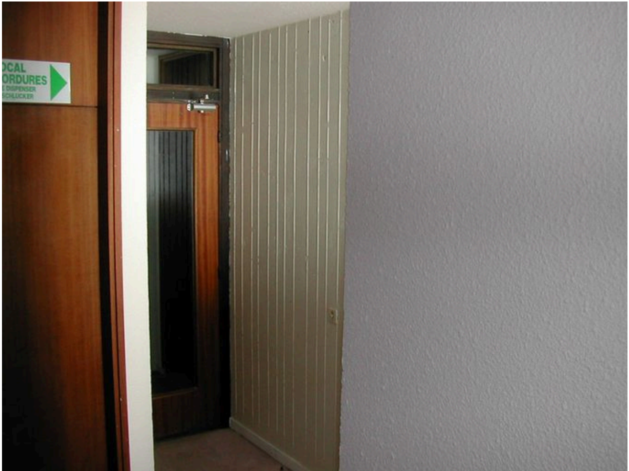
L'entrée. Détail de l'enduit des murs des parties communes
