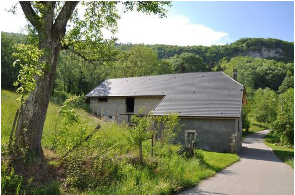
Autre vue générale du bâtiment du moulin
