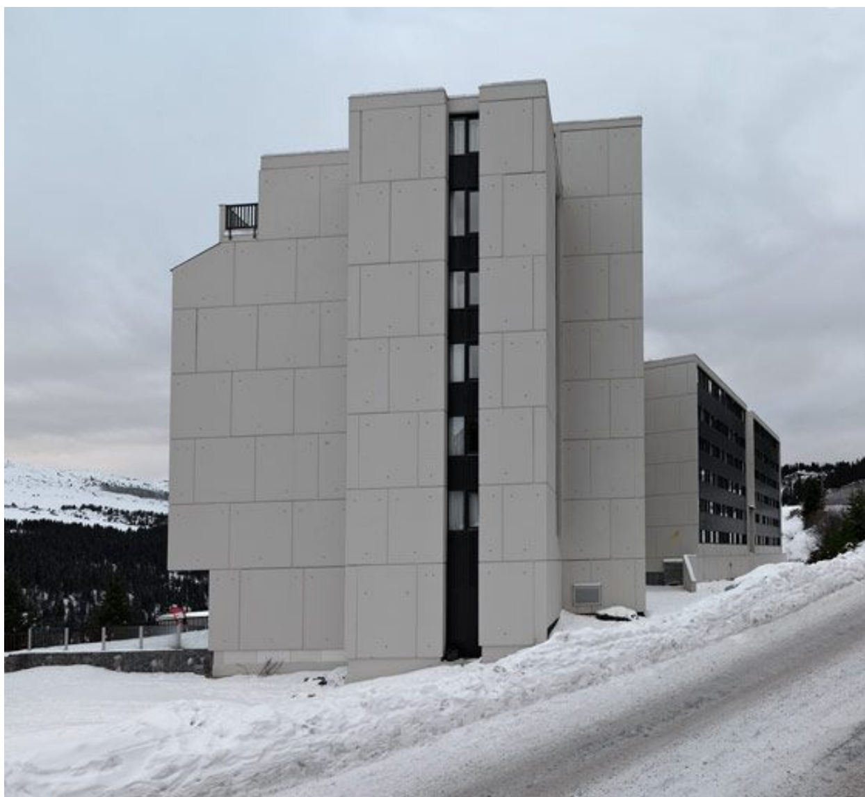
Le pignon sud
